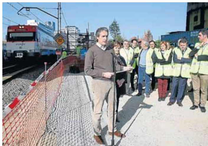
Íñigo de la Serna, titular de Fomento, durante su visita a las obras de mejora del ferrocarril vasco.
