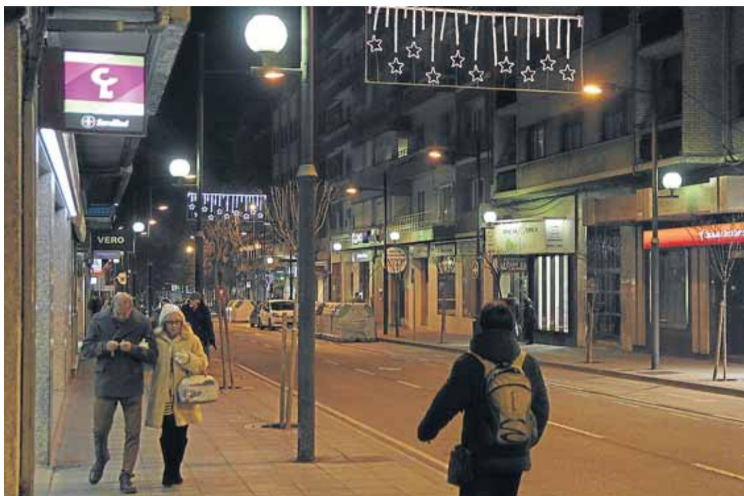
En la calle Zaragoza se han instalado reguladores del alumbrado público.
