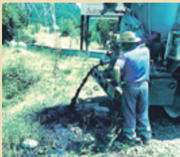
Vertido realizado desde un camión. S.E.
