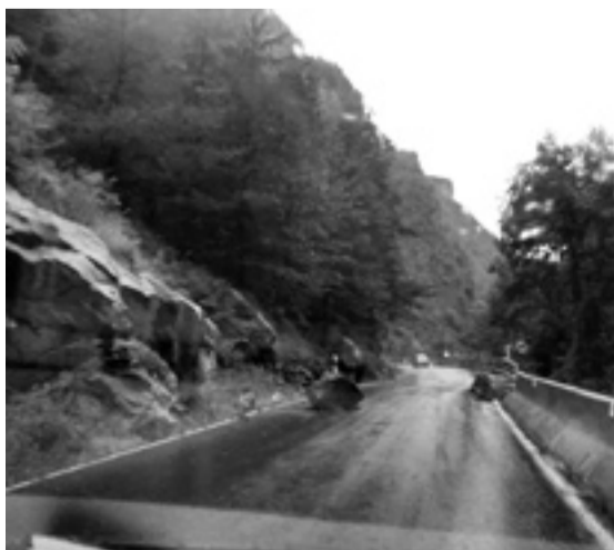
Rocas caídas a la carretera en el Congosto de Ventamillo. s.e.
