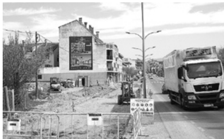
Obras de prolongación de la calle Joaquín Costa de Graus. E.F.
