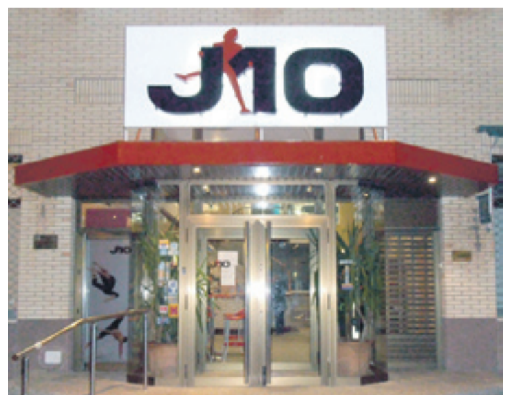
Puerta principal del Centro Deportivo J10 de Huesca.
