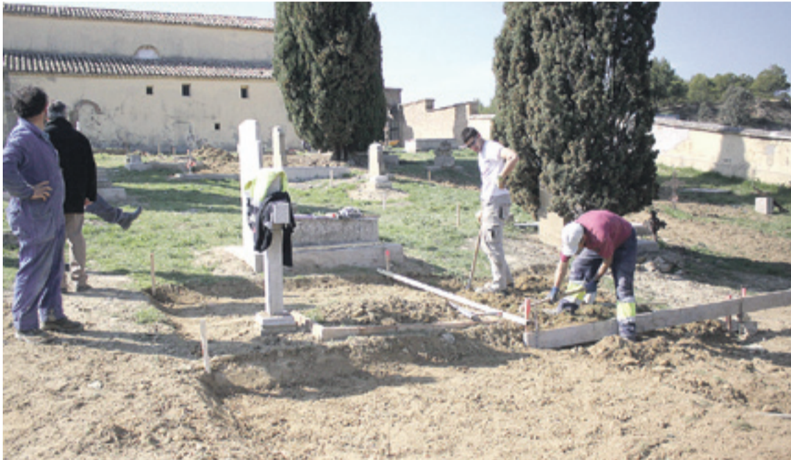
En el cementerio, se ha trabajado en los muros y se consolida el terreno, en el que habrá pequeñas zonas con plantas. P.S.
