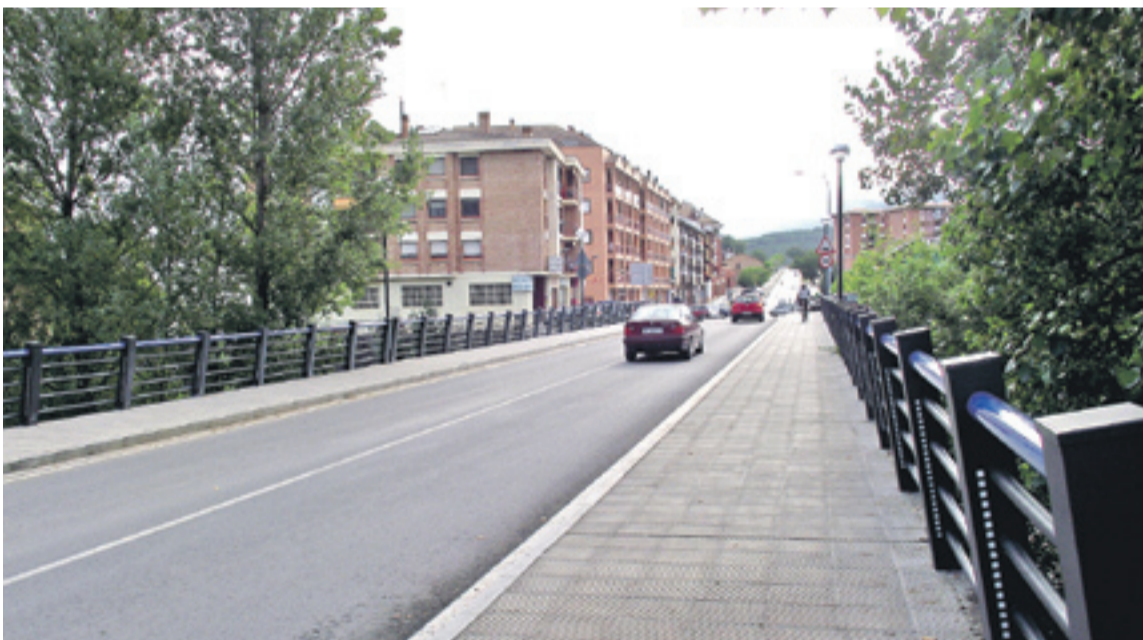
El ensanche de las aceras del Ésera ha sido una de las obras principales de este año. E.F.
