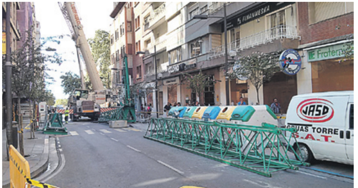
Imagen de la grúa ubicada en la calle de Zaragoza. o.s.
