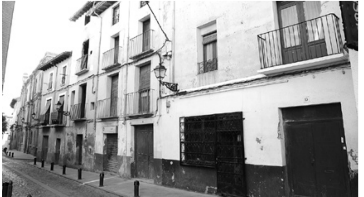
Una de las manzanas de la calle de las Cortes con edificios deteriorados. VÍCTOR IBÁÑEZ
