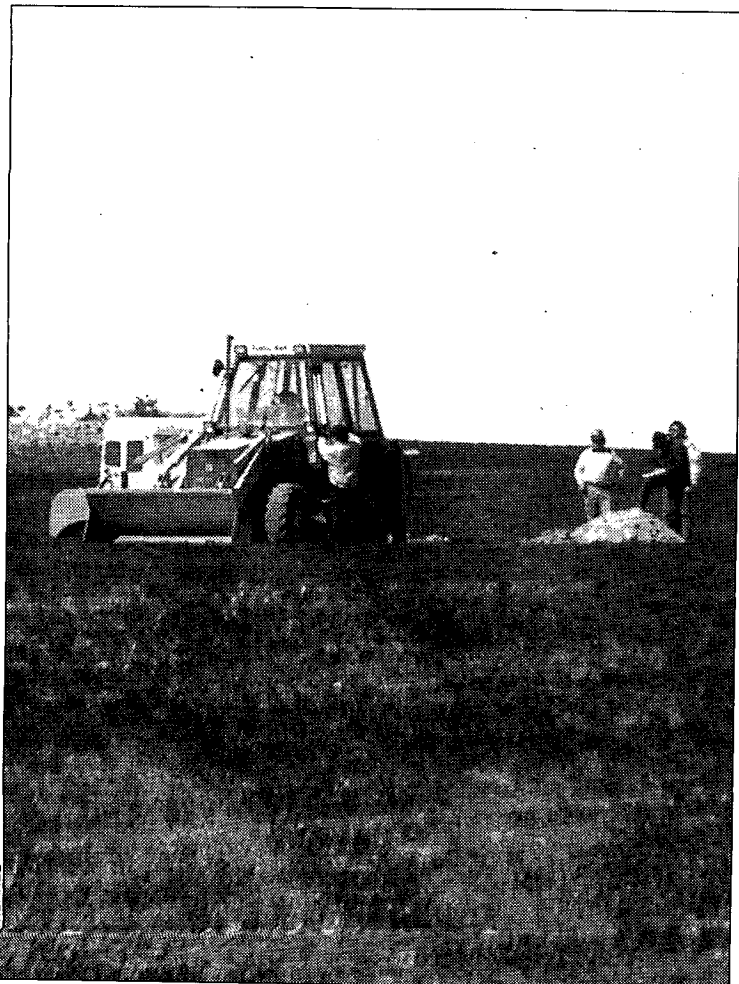
Un momento de los trabajos que comenzaron ayer en la zona de Puilatós.
